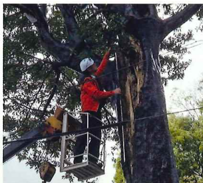
高所作業車を使った診断 (亀山市関神社)
