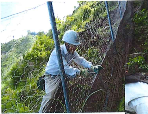
獣害防止ネットの設置(上) 在来種の種を埋める作業(中央) 苗木の植栽(右)
